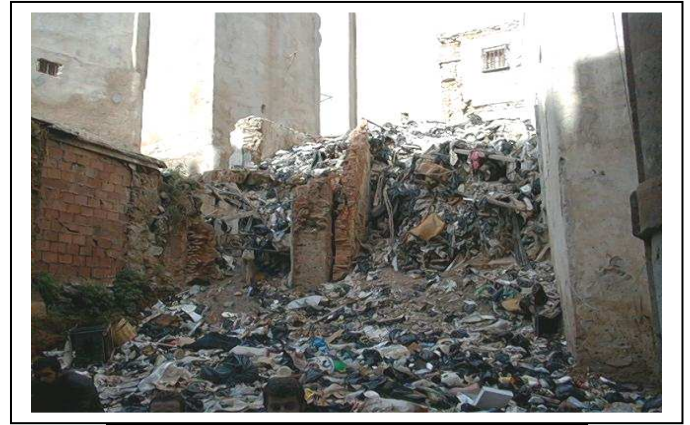
Décharge sauvage dans la casbah Ilot Amar El Kama
