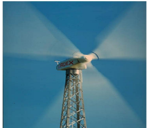
Figure I-5 : éolien avec pylône en treillis.
