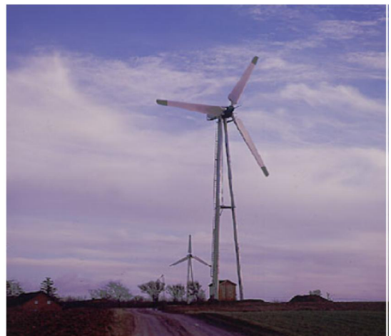
Figure I-7 : éolienne avec tour à trois pieds.
