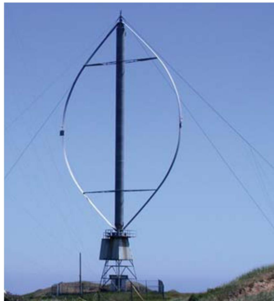
Figure I-3 : Éolienne dite de Darrieus à axe verticale.
