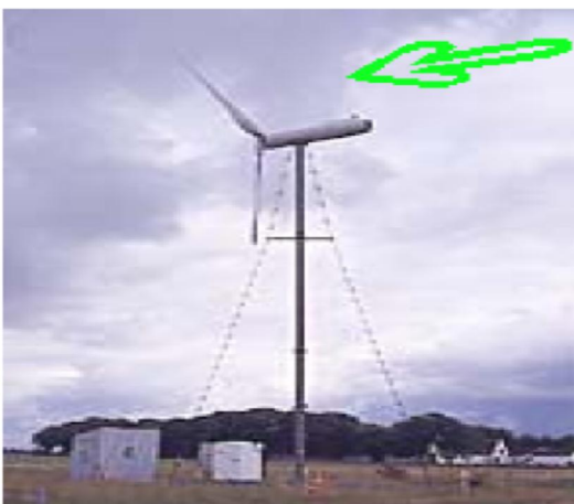
Figure I-6 : éolienne avec pylône haubané.
