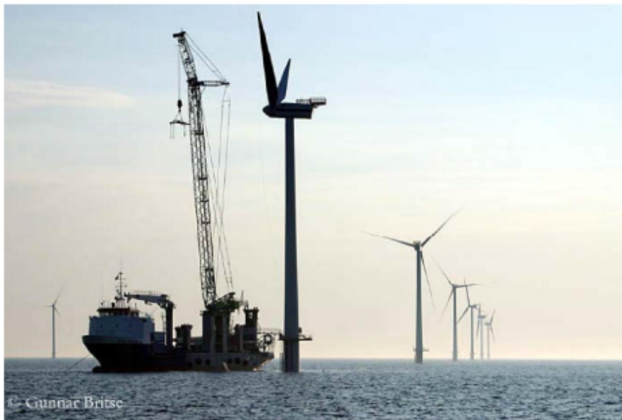
Figure I-1: Installation d'éoliennes offshore en mer du nord.
