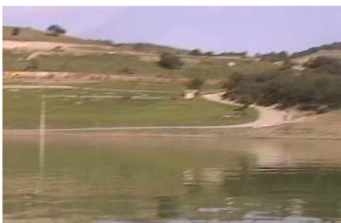
Figure 7: Vue générale de la station B du barrage de Boukourdane
