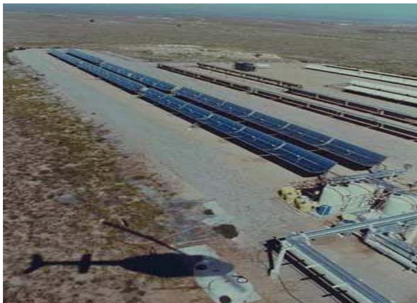
Figure.II.13. Réacteur tubulaire à collecteur parabolique.
