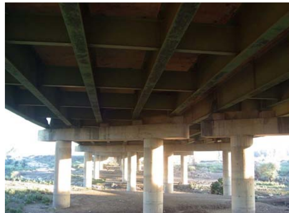
Figure 1.7 : Voilement de la poutre de rive d'un pont sur Oued El Harrach sens Ben Aknoun -Dar El Beida suite au séisme de Boumerdès en 2003 [29]
