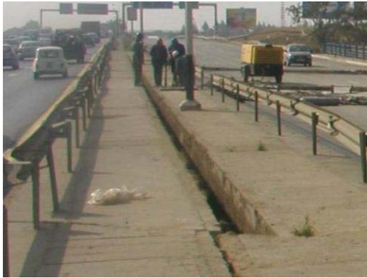
Figure 1.11 : Déplacement du tablier du viaduc d'El-Harrach [29]
