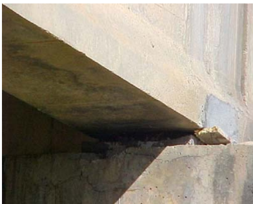
Figure 1.13 : Ecrasement de l'appareil d'appui/détérioration de l'appui de Pont sur Oued Sebaou [29]
