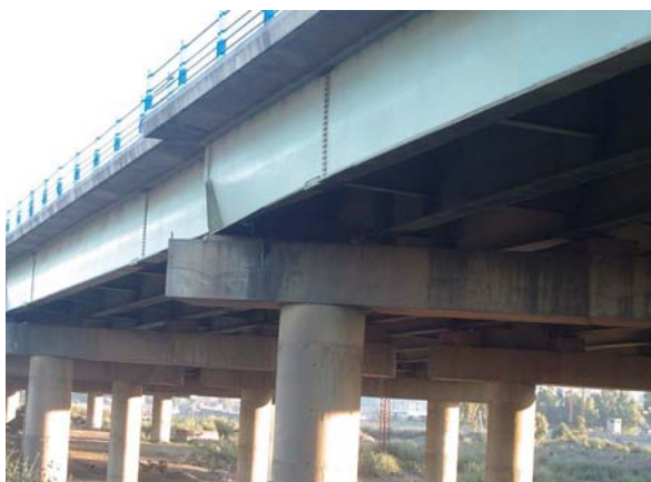
Figure 1.7 : Voilement de la poutre de rive d'un pont sur Oued El Harrach sens Ben Aknoun -Dar El Beida suite au séisme de Boumerdès en 2003 [29]
