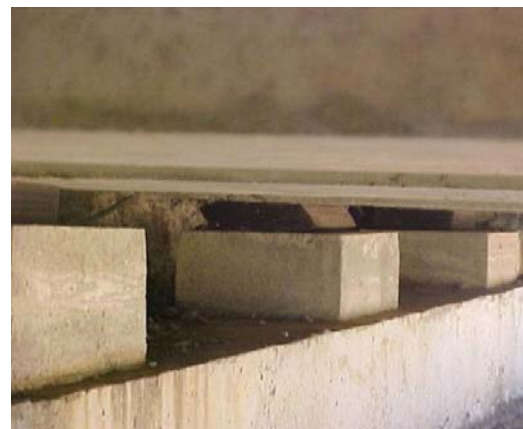
Figure 1.13 : Ecrasement de l'appareil d'appui/détérioration de l'appui de Pont sur Oued Sebaou [29]
