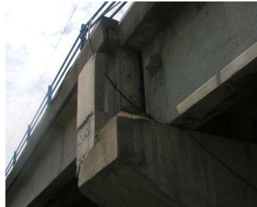
Figure 1.12 : Déplacement latéral du tablier de Pont sur Oued Sebaou [29]
