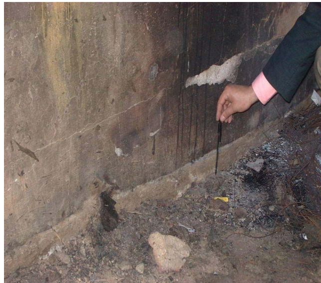
Figure 1.9 : Affaissement du sol au niveau de la pile [29]
