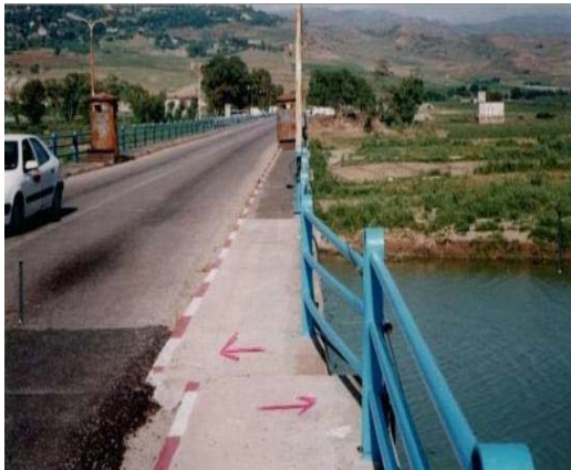
Figure 1.12 : Déplacement latéral du tablier de Pont sur Oued Sebaou [29]
