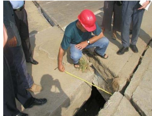
Figure 1.11 : Déplacement du tablier du viaduc d'El-Harrach [29]
