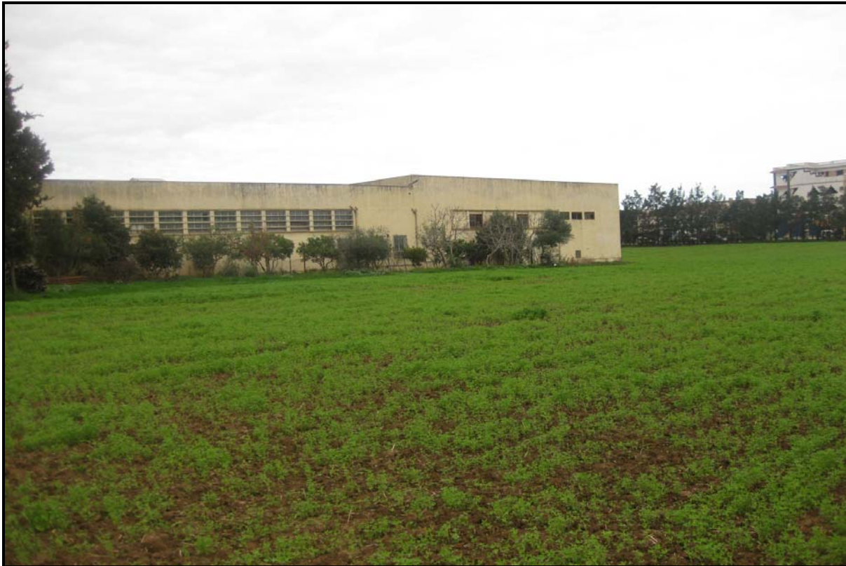
Fig.8 : Vue d'ensemble de la station A.
