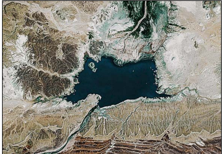
Fig.IV-1 Barrage de Djorf Torba vu par satellite (source : Google earth)
