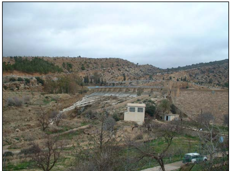
Fig.IV-6 Barrage de Foum ElGueiss (source : Agence Nationale des Barrages et Transferts)
