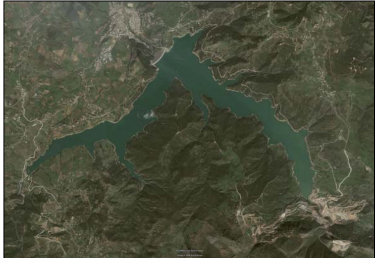
Fig.IV-3 Barrage de Kaddara vu par satellite (source : Google earth)
