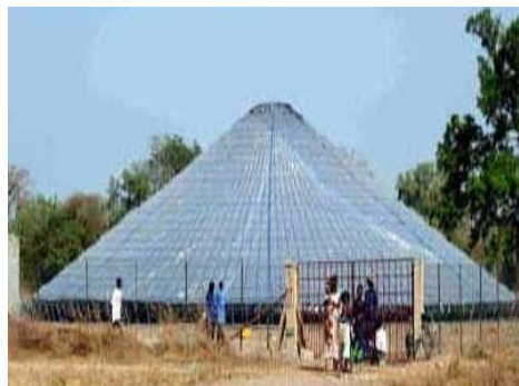
Fig.1.6 : Distillateur solaire, de forme pyramidale avec un couvercle en film plastique, couvrant une surface de 600 m 2 et produisant 1250 litres/jour.
