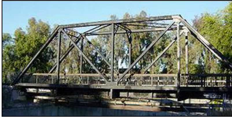
Figure 4.3 : Pont à poutres en treillis [12]
