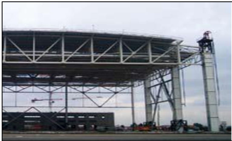
Figure 4.2 : Hangar avec des poutres en treillis (fermes métalliques) [12]
