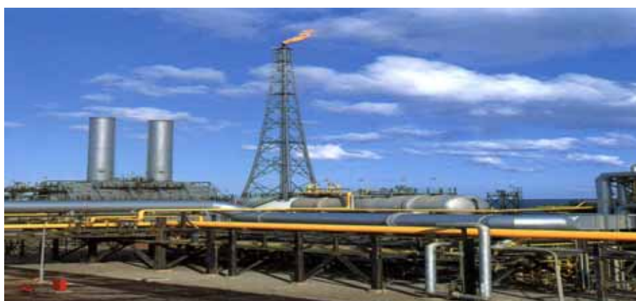
Figure I.4. Photos de torches du complexe de liquéfaction du gaz naturel d'Arzew.
