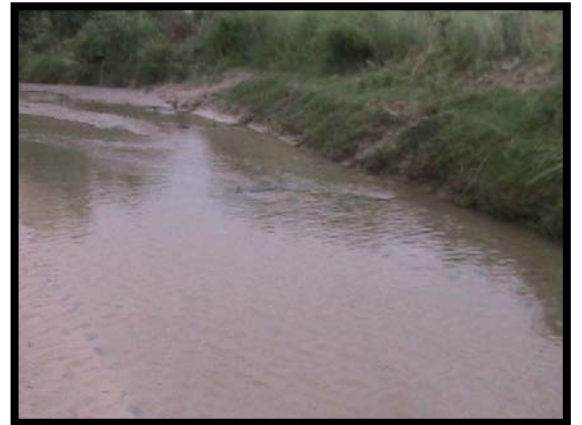
Figure 15 : Vue globale de la station AEK
