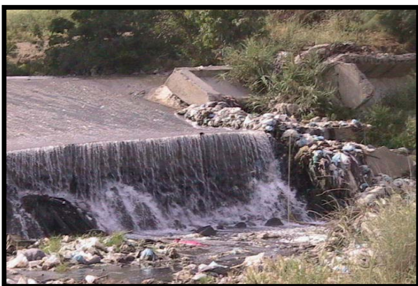
Figure 10 : Vue globale des rejets urbains au niveau de l'oued El Hammam
