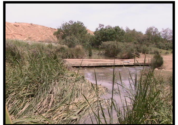
Figure 21: Vue globale de la station ASS
