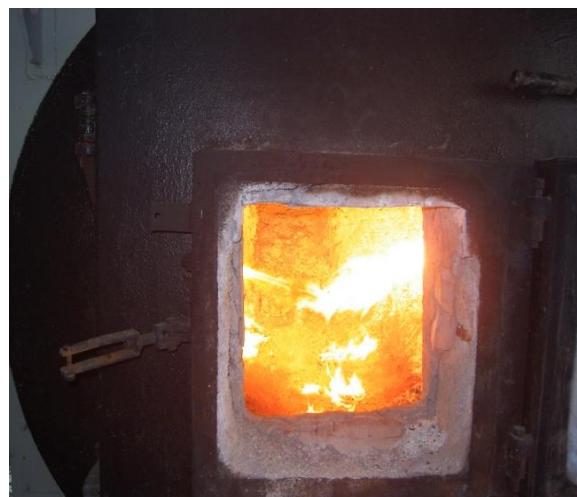
Photo I.2. L'entrée du four.
