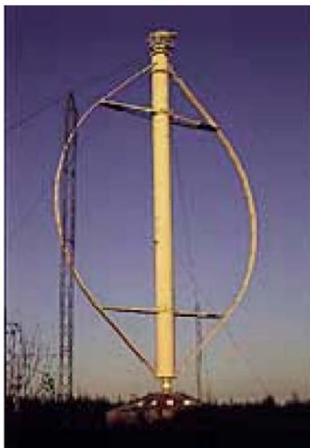
Figure I-2 : Eolienne de Dorrieus de 4.200 kW et 100 m de diamètre
