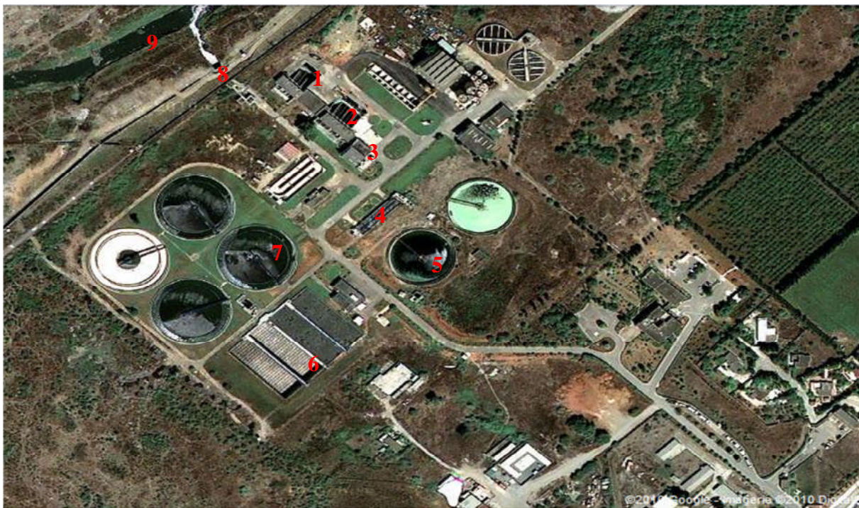
Figure 22 : Station d'épuration de BARAKI.
