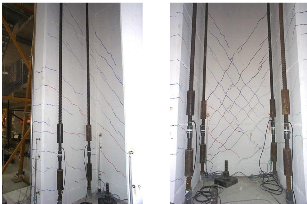
a) Fissuration des ailes
