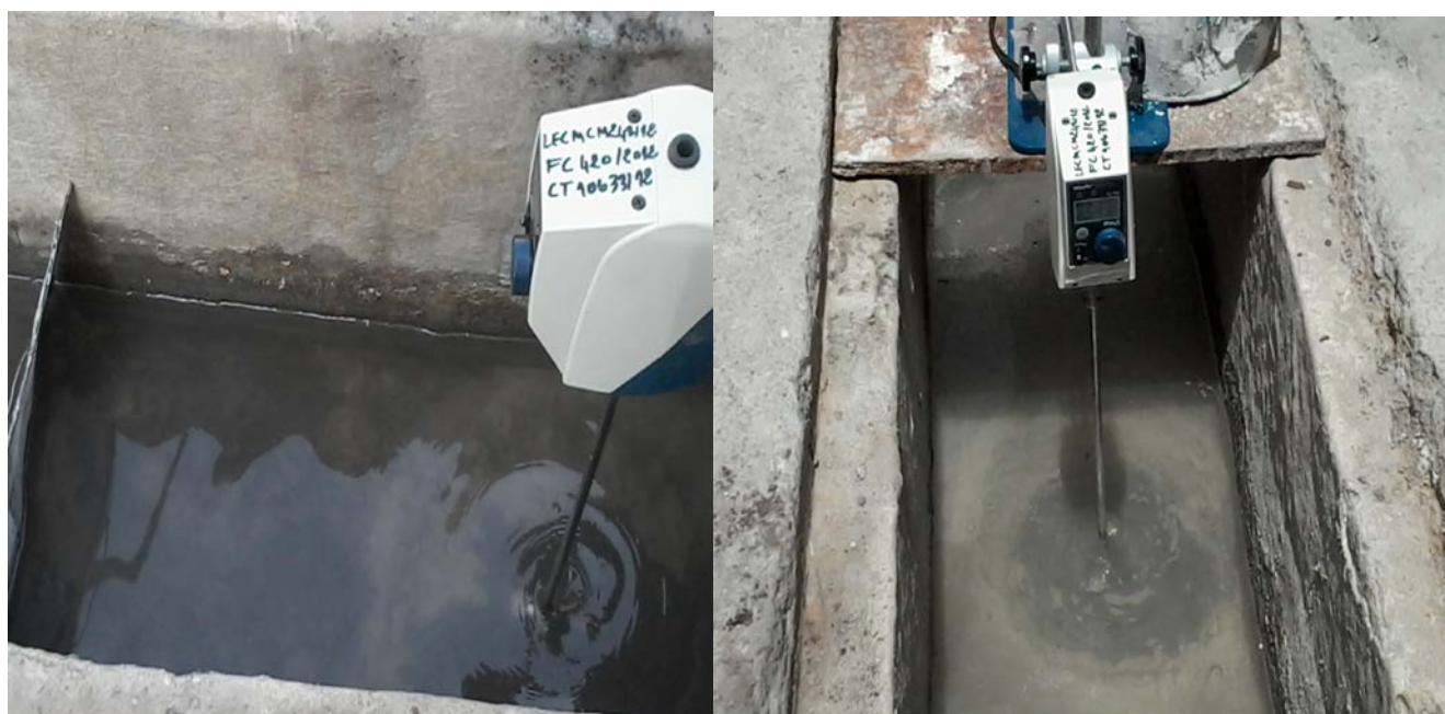
Fig.V.36 Photos du dispositif de l'élimination des ions Pb^{2+} utilisé sur site
