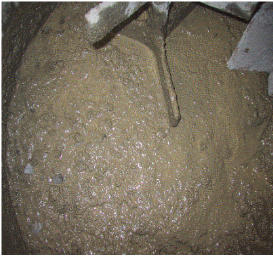
Figure 3.5 : Confection du béton autoplaçant
