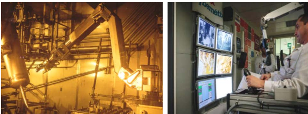
Figure 1.9 : Démantèlement d'une installation nucléaire à l'aide d'un bras téléopéré.
