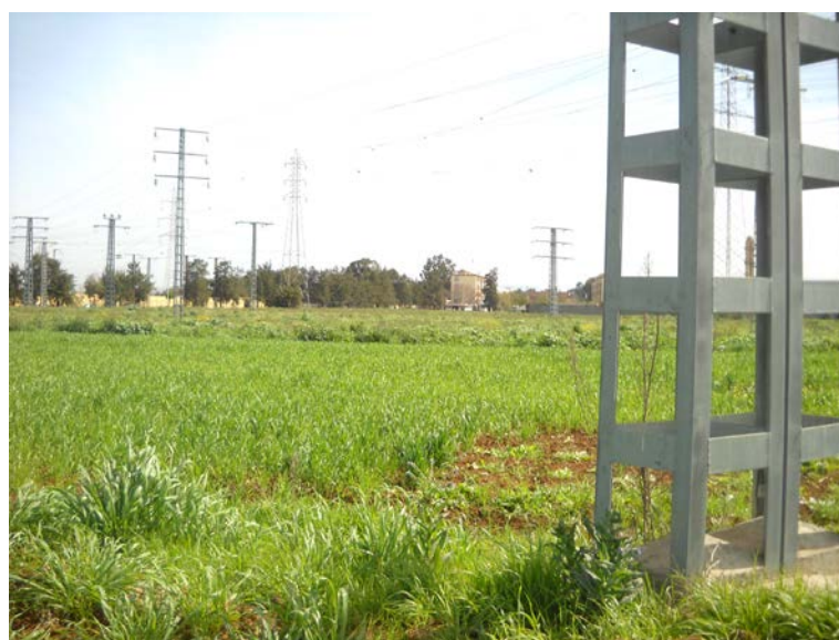
Figure 7 : Vue générale de la station B.
