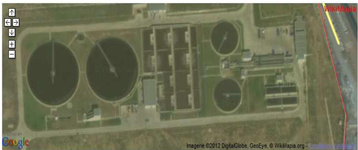
Figure 28 : vue générale de la station d'épuration.
