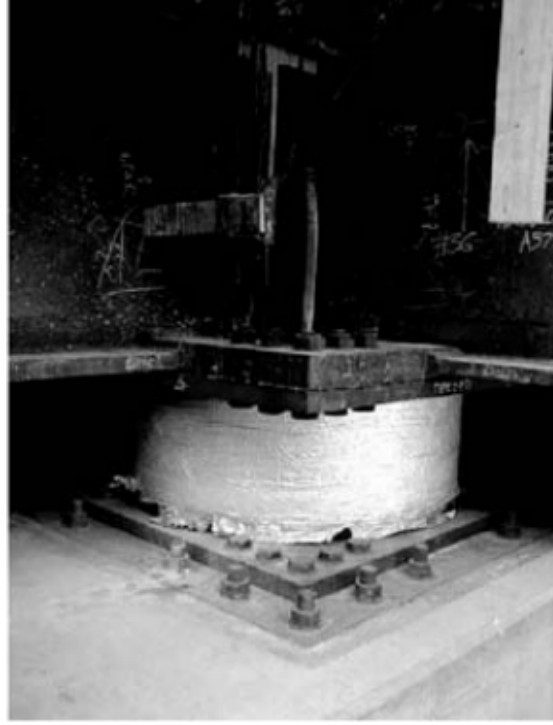
Figure 1.1 (a) La construction d'un hôpital presbytérien à la Californie et (b) Installation d'un système d'isolation de base.
