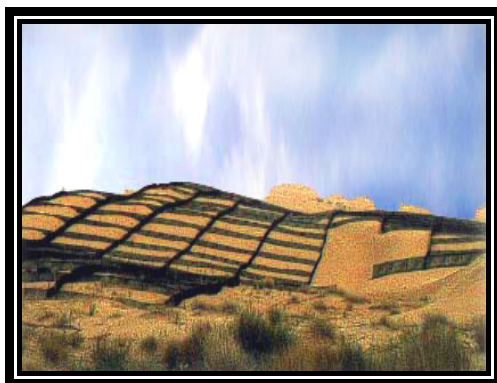
Figure 8 : Dunes avant et après la fixation à l'aide des mailles en plastique.
