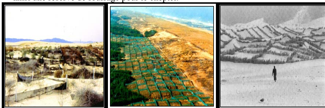
Figure 7 : Techniques de fixation des dunes à l'aide des mailles en plastique noires et vertes et en fascines d'espèces végétales.
