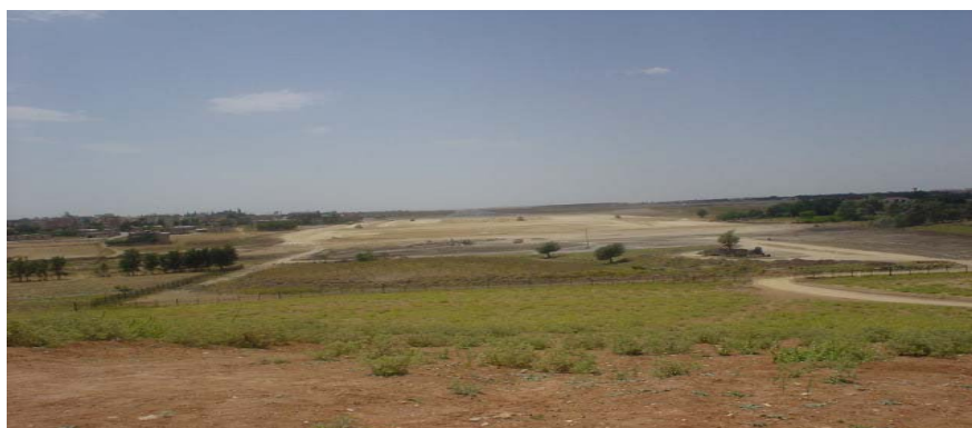
Fig.2.1 - Vue du site du projet de l'Aéroport de Ain Arnat à Sétif
