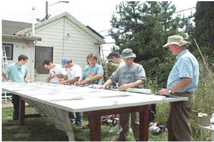
Figure II-4. Image du système PV en cours d'installation dans une maison à Palo Alto
