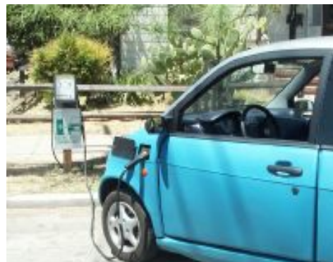
Figure III-9. Véhicule électrique en cours d'alimentation grâce à l'énergie solaire
