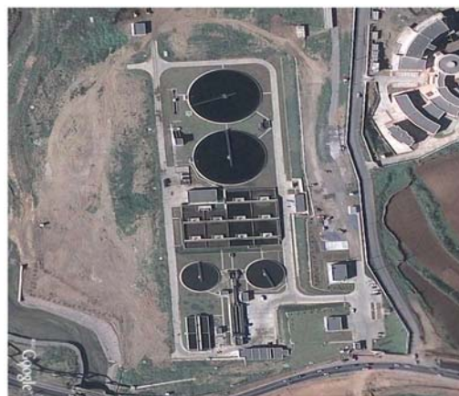
Figure II-2 : Station d'épuration de Aïn Benian
