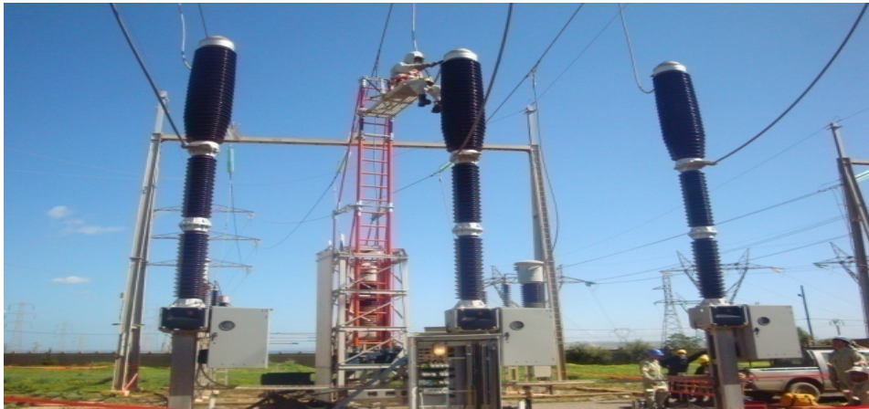
Photo 4.1 : Travail sous tension sur un disjoncteur 220kV dans un environnement triphasé.
