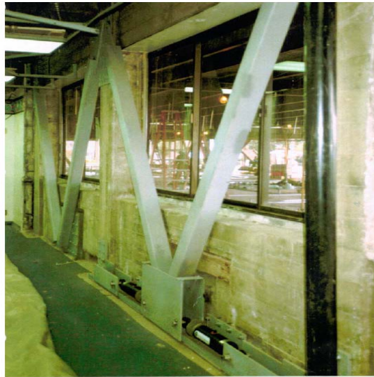
Figure II.9 Système de contreventement en acier avec amortisseurs visqueux disposés horizontalement
