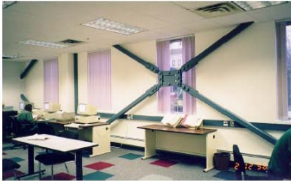
Ossature contreventée par des Amortisseurs à frottement
