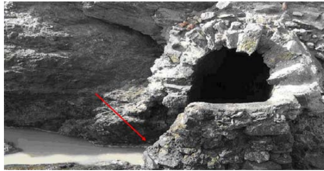
Figure 39. Déversement d'un collecteur d'eau usée de la commune boudoulienne dans la station 6 (deux châteaux)
