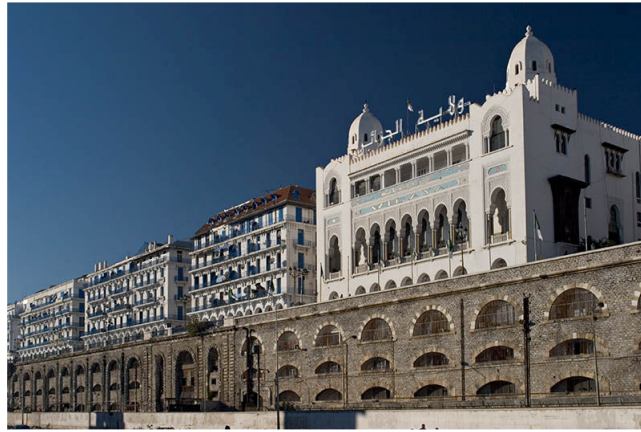
Fig. 53': Siège de la wilaya d'Alger.
