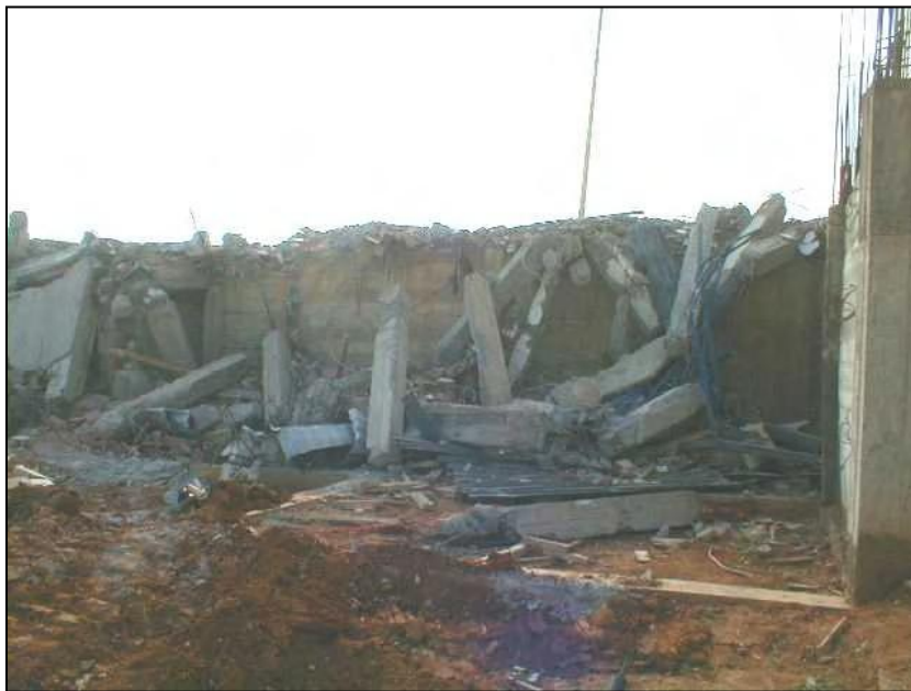
Figure1.6: Construction après démolition à Birkhadem.
