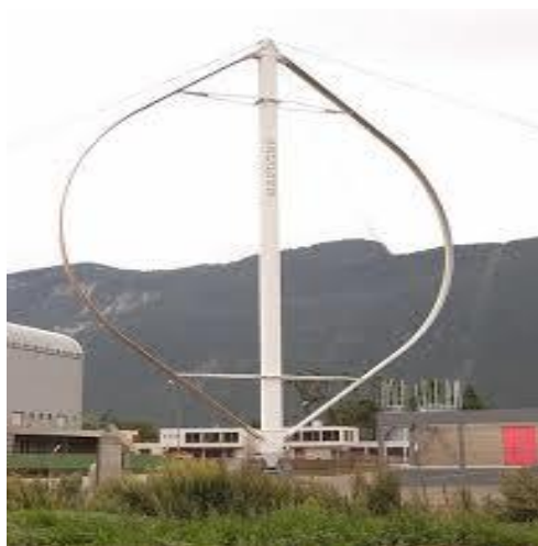
Figure (1.3) : Aérogénérateur à axe vertical (structure de Darrieus).
