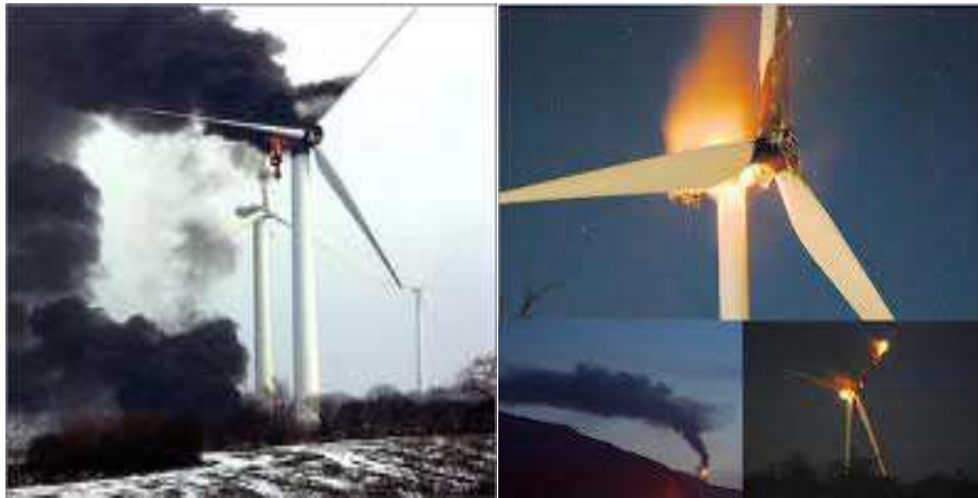
Figure (1.20): Conséquence des défaillances des génératrices des éoliennes [Ouyessaad, 2014].
