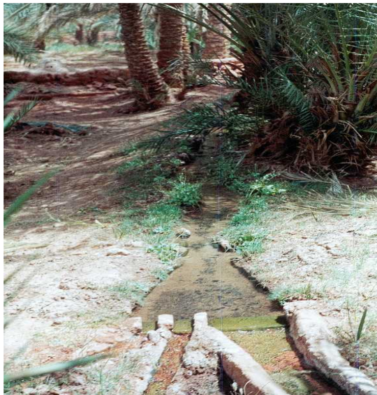
Figure 41: Peigne secondaire d'une foggara de Tamentit
