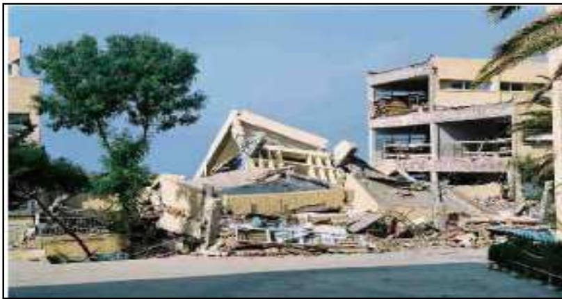
Photo B-I-1: Effondrement dû à l'absence du contreventement [2]
