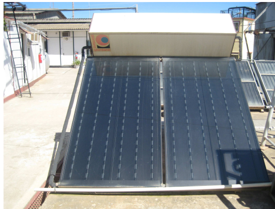
Fig. I.2 Le capteur solaire à circulation liquide (CDER)
