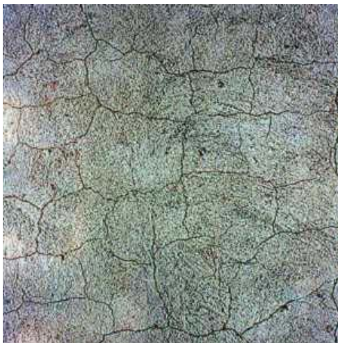
Figure 2.1 : Réseau de fissures de surface [54].
