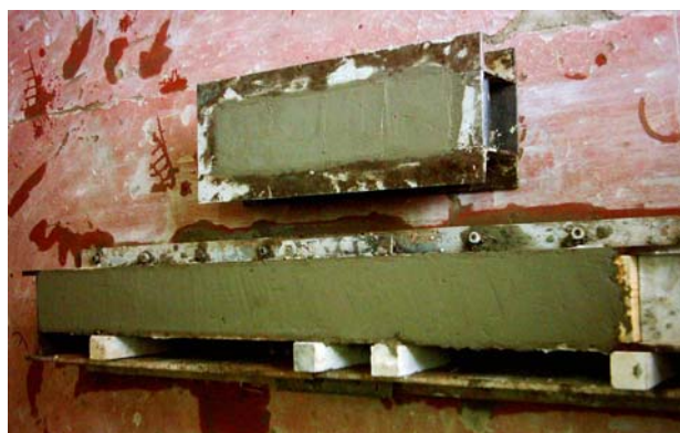
Figure 6.16 : coulage des poutres
