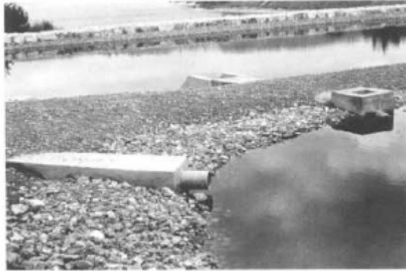
Photo 5 : ouvrages de communication entre les bassin
