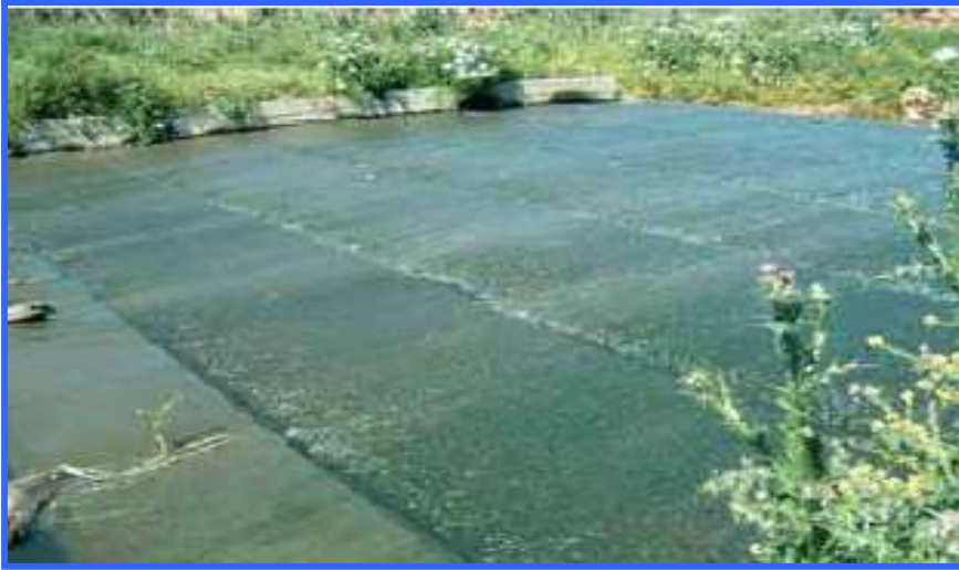
Photo 6 : vue de la sortie des eaux du quatrième bassin.
