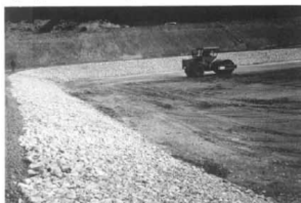
Photo 4 : Protection du talus amont par petits enrochements
