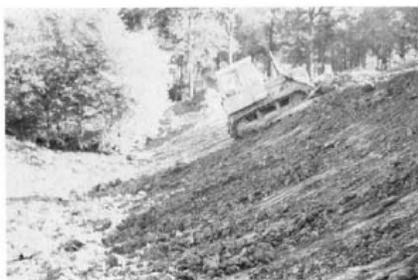
Photo 3 : protection du talus aval par terre végétale
