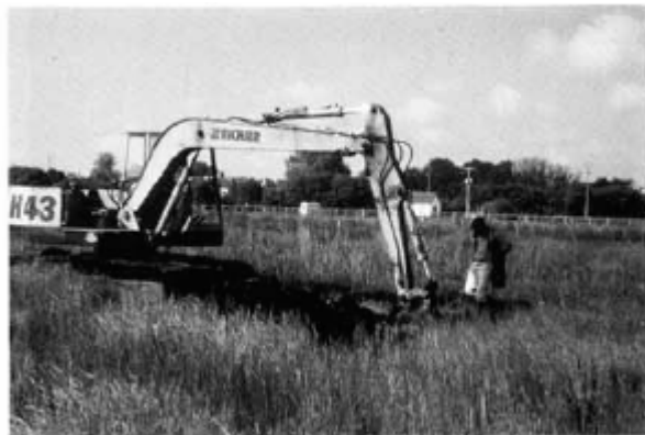
Photo 6: reconnaissance par pelle mécanique du site choisi
