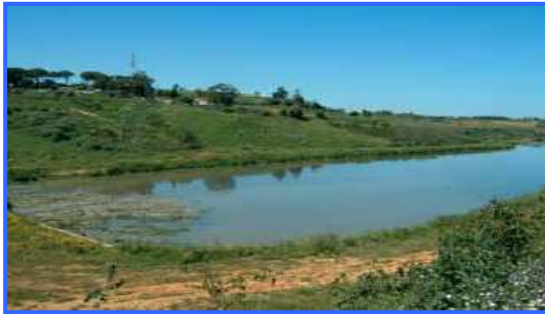
Photo 4 : vue générale du premier bassin.
