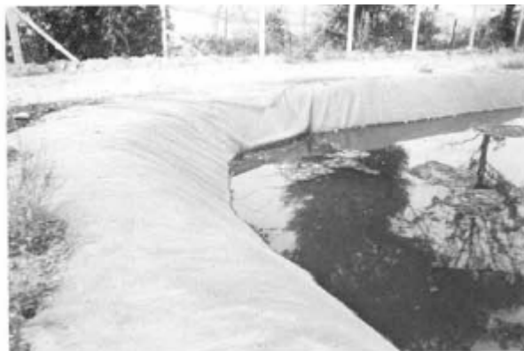
Photo 2 : Digue étanchée par une géomembrane
