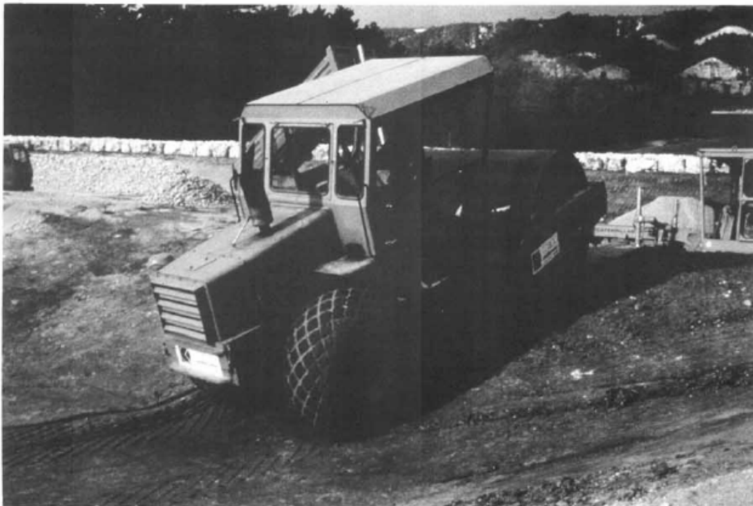
Photo 1 : Compactage d'un tapis d'argile sur talus par un rouleau lisse
