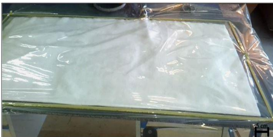
Figure II.19 Début de mise sous vide
