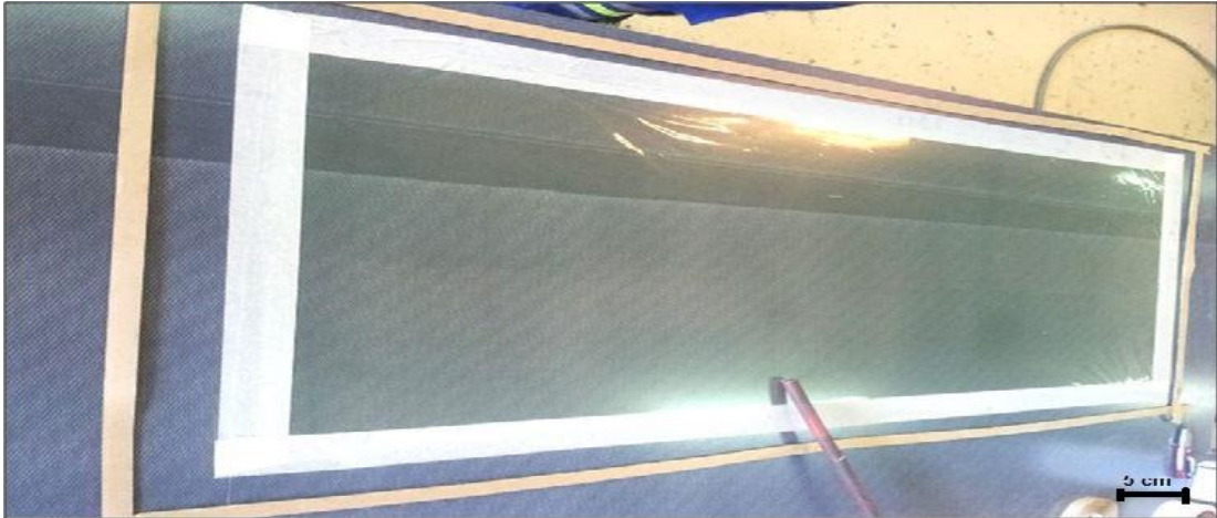
Figure II.11 Dépôt du mastique d'étanchéité
