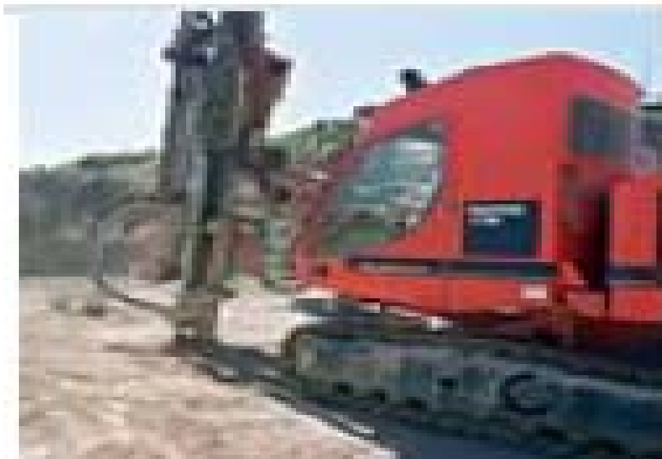
Photo I.3. Installation des explosifs
