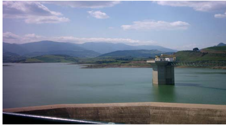
Figure 18: Vue générale de La station 5 avec la tour de prise
